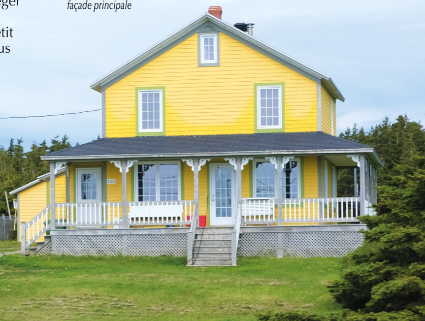
Maison caractéristique du canton des Caps avec la lucarne brisant la ligne de toit de la façade principale
