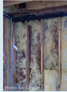
Illustration 2 : Dommages causés par l'humidité. [Gauche] Isolant dans le mur [Droite] Contreplaqué dans les combles
