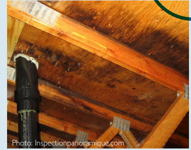
Illustration 2 : Dommages causés par l'humidité. [Gauche] Isolant dans le mur [Droite] Contreplaqué dans les combles
