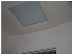
Illustration 3 : Pertes de chaleur par la trappe du grenier
